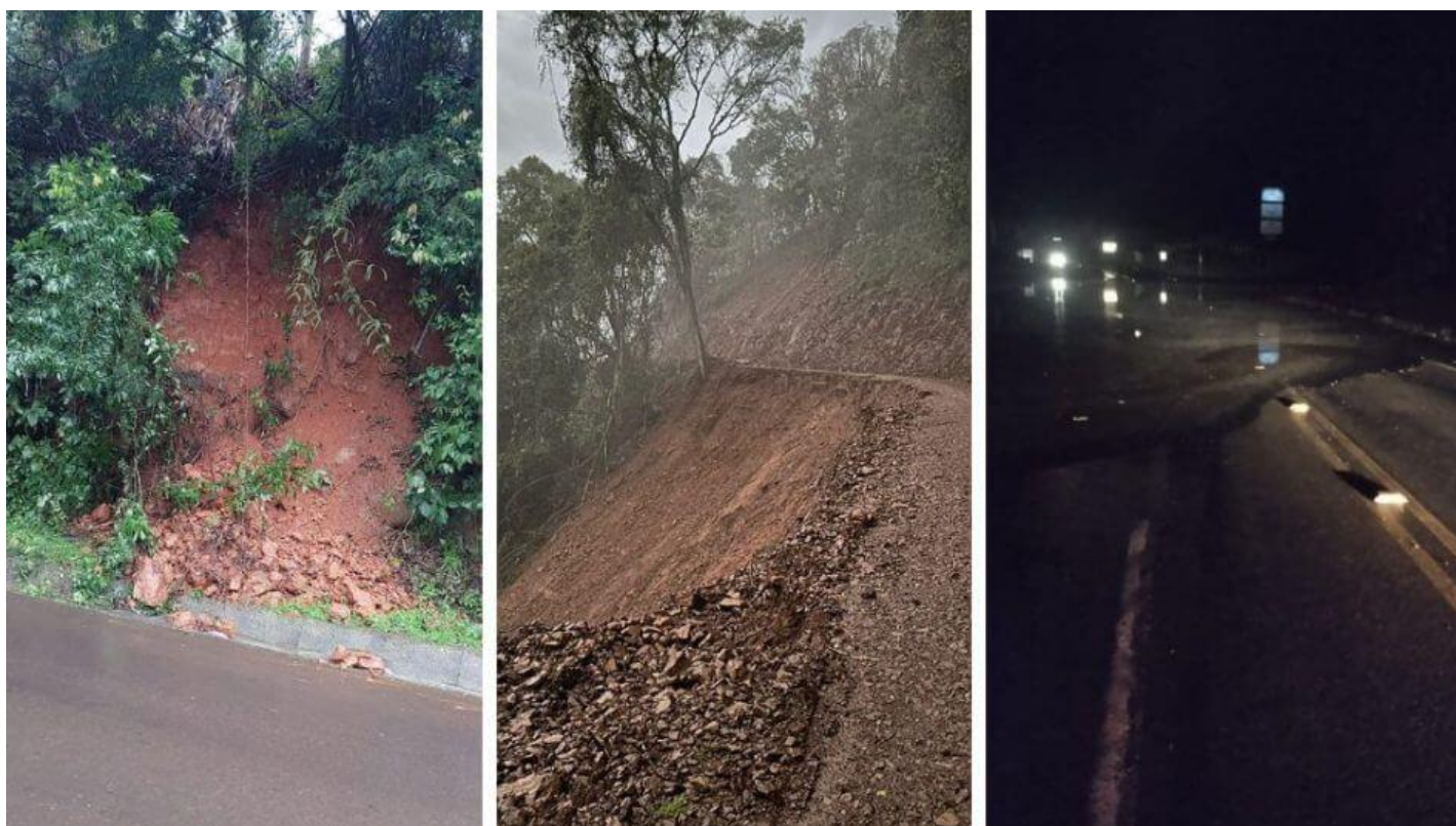
Chuva causou deslizamentos e alagou rodovias em SC (Foto: NSC TV/Reprodução)
