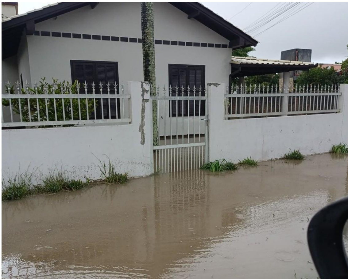
Cidade de Imbituba, no Sul de Santa Catarina, registrou alagamentos nesta manhã — Foto: Prefeitura de Imbituba/Divulgação
